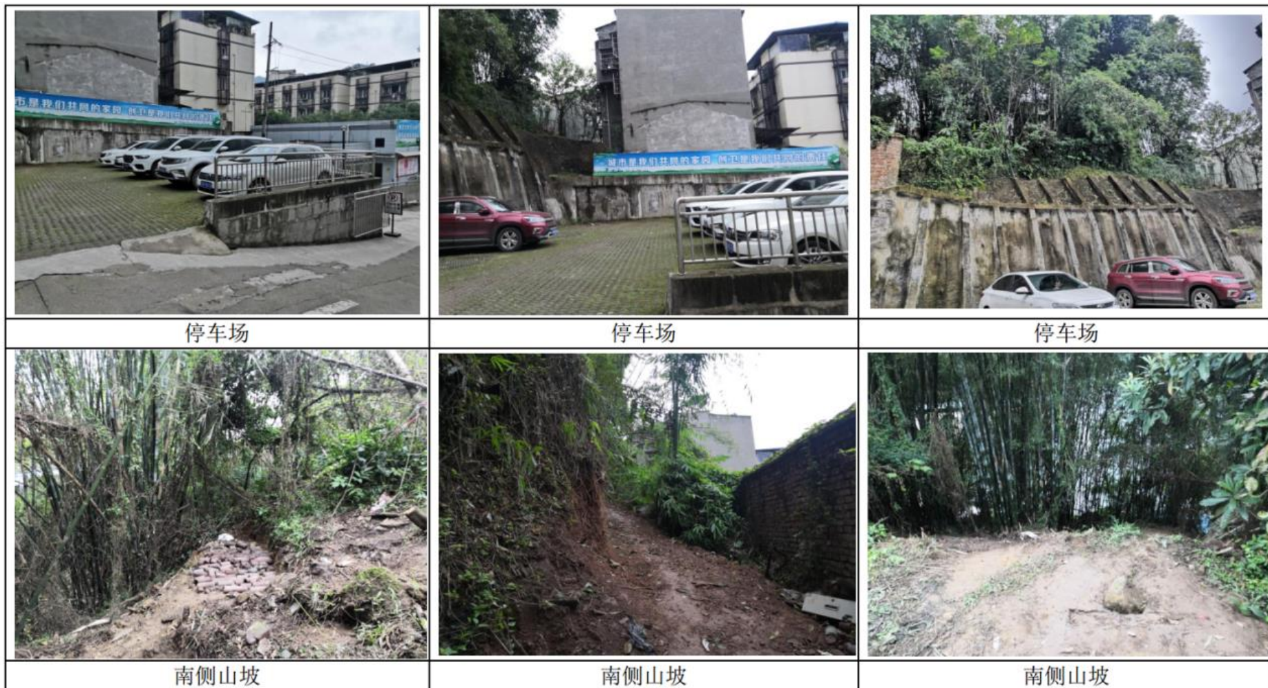
附图3 现场踏勘照片
